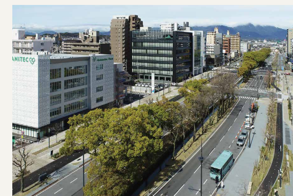
四日市中央線道路整備工事(その2)
