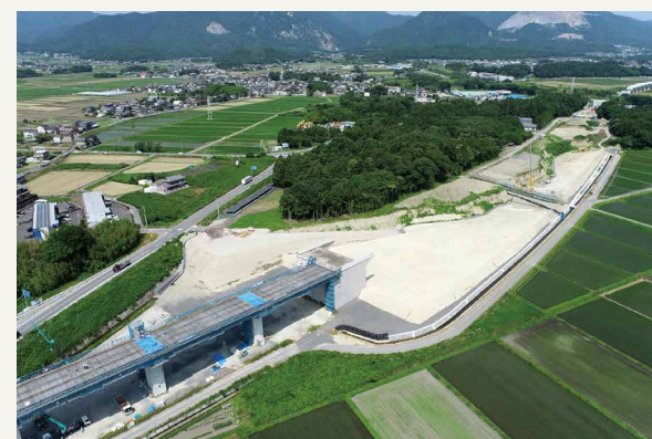
東海環状麻生田地区南部道路工事
