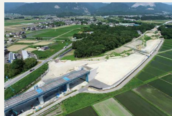
東海環状麻生田地区南部道路工事
